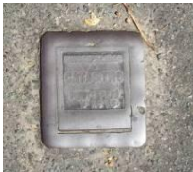
Figura 2: Monumentación de punto sobre pavimento
